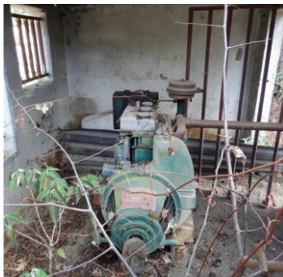
Figura N° 3. Caseta para bombeo y bomba de diésel Fuente: Valdez-Samaniego, (2018).
